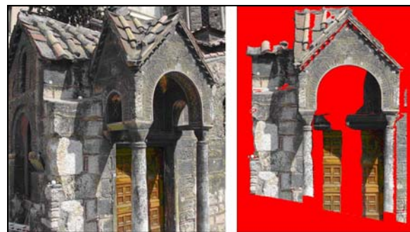
Εικόνα 18. 'Αληθής' ορθοαναγωγή εικόνας. Figure 18. 'True' orthoprojection of an image.
