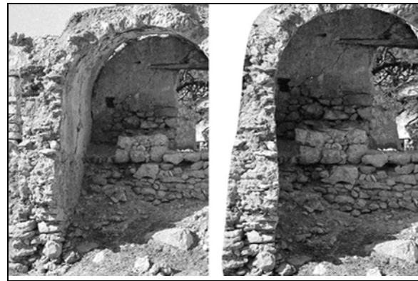
Εικόνα 13. Αρχική εικόνα και ορθοφωγραφία. Figure 13. Source image and orthomosaic.
